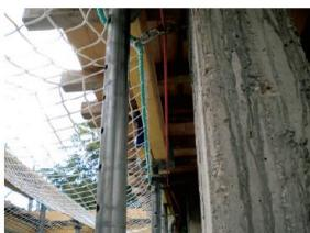
Figura 26 – Dettaglio ancoraggi intermedi della rete ai pilastri e alla fune di bordo
